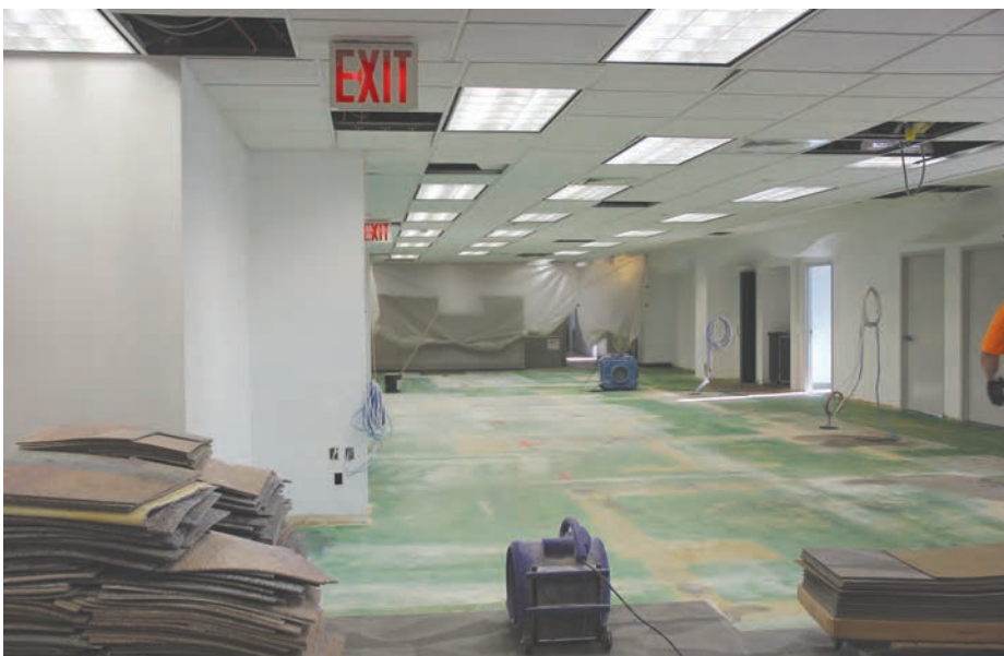
Renovación del área donde el espacio de trabajo del Grapevine estará situado
